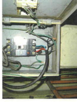
การเชื่อมต่อสายไฟฟ้าที่ไม่ได้มาตรฐาน
