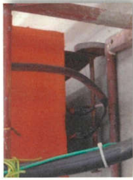
เครื่องใช้ไฟฟ้าที่ไม่มีการต่อสายดิน (Ground) อันตราย
